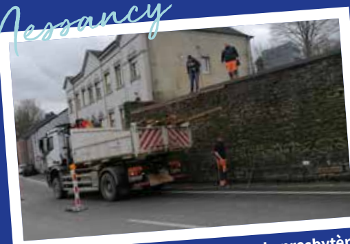
Travaux de soutènement du mur du presbytère
