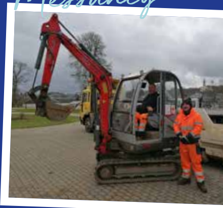
Remblais de copaux pour sécuriser la plaine de jeux
